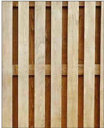
Habillage de la façade par un bardage bois 122m²
